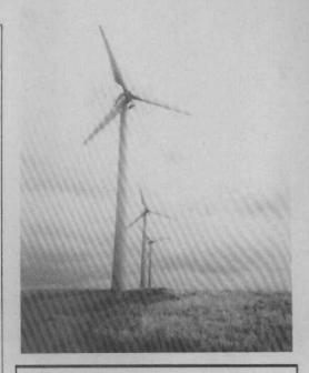
Das Konzept der AN-Bonus 150/30 kW Windenergieanlage - Rotor mit horizontaler Achse, Rotorblätter mit festem Anstellwinkel, ein Generator( polumschaltbar 150 bzw 30 kW), Netzparallelbetrieb, Stall-Regelung - ermöglicht die wirkungsvolle Windenergienutzung bei geringem Wartungsbedarf. Alle Komponenten sind großzügig dimensioniert, sorgfältig aufeinander abgestimmt und haben einen hohen Qualitätsstandard. So erreichen wir eine lange Lebensdauer.
