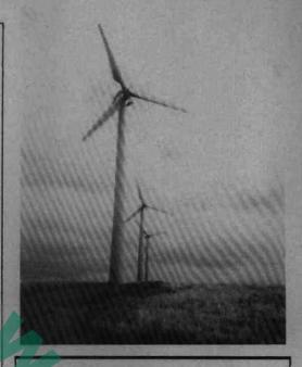
Das Konzept der AN-Bonus 150/30 kW Windenergieanlage - Rotor mit horizon-taler Achse, Rotorblätter mit festem Anstellwinkel, ein Generator( polum-schaltbar 150 bzw 30 kW), Netzparallel-betrieb, Stall-Regelung - ermöglicht die wirkungsvolle Windenergienutzung bei geringem Wartungsbedarf. Alle Komponenten sind großzügig dimen-sioniert, sorgfältig aufeinander abge-stimmt und haben einen hohen Qualitäts-Windenergieanlage - Rotor mit horizonstandard. So erreichen wir eine lange Lebensdauer.
